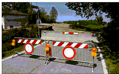
Il ponte sullo scolo Paluvecchio è chiuso al traffico dal 2021
