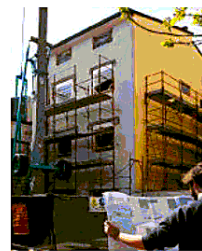
Il cantiere a Porto
